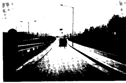
그림 42 포장 균열 보수 완료
