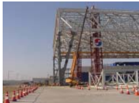
<그림 2-9> 기둥 설치
