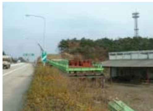
<그림 2-2> 가교 No.1 현장현황 사진
