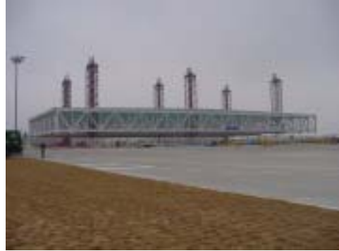
<그림 2-7> 1차 Lifting
