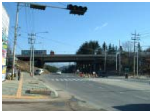
<그림 2-6> 가교 No. 3 현장현황 사진
