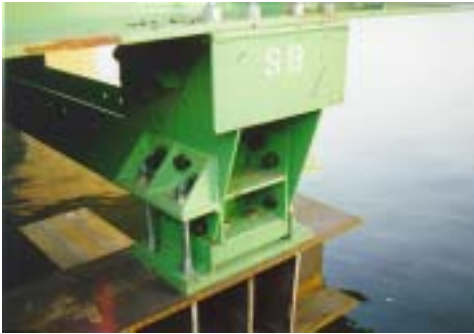
<그림 3-6> Shoe 설치
