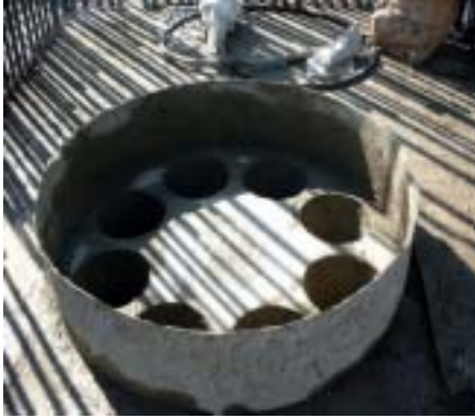
&lt;그림 2-7&gt; 콘크리트 사일로
