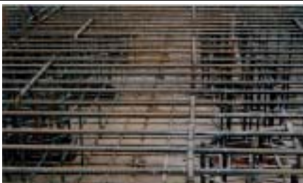
9. 강관상부 주철근 및 보강철근 배근
