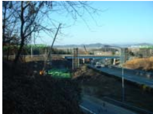
<그림 2-4> 가교 No. 4 현장현황 사진
