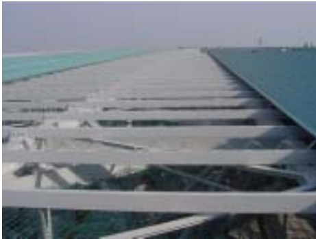
&lt;그림 3-6&gt; 하부판넬 설치
