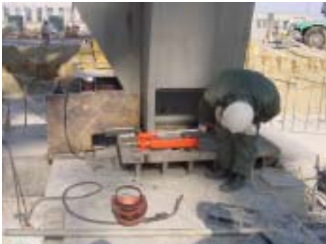
<그림 2-10> Presetting 장면
