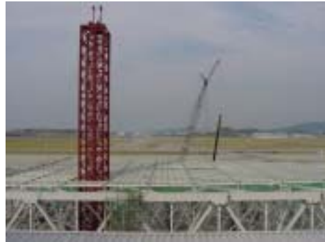
<그림 2-3> Lifting Tower
