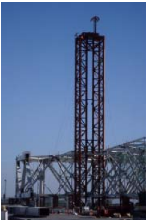
<그림 3-1> Lifting Tower
