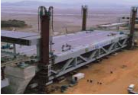
<그림 2-6> Strand Jack을 이용한 설치
