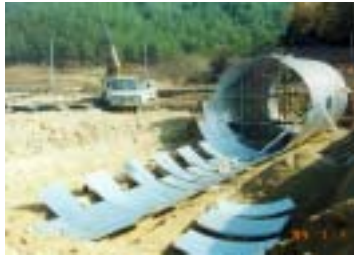
(3) 측상부 강판 조립
