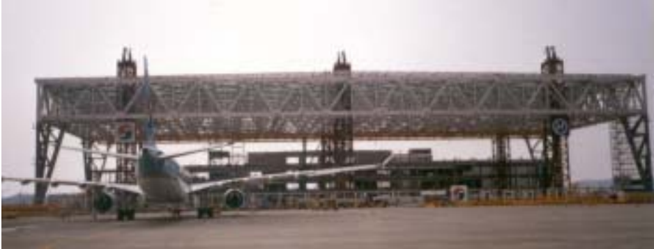
<그림 4-4> Lowering 및 Presetting이 완료된 상태
