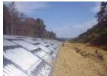
(4) 파형강판 측면 뒷채움 및 다짐
