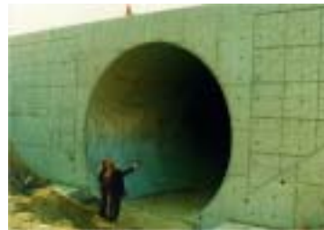
(6) 날개벽 설치 및 완공
