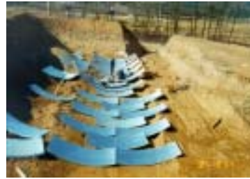
(2) 하부 강판 조립
