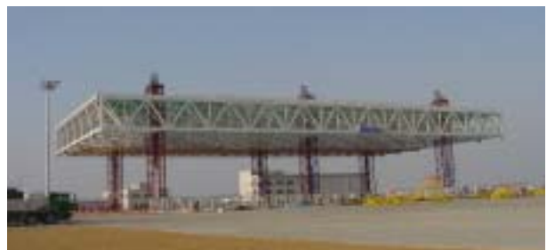
<그림 4-3> Lifting 완료
