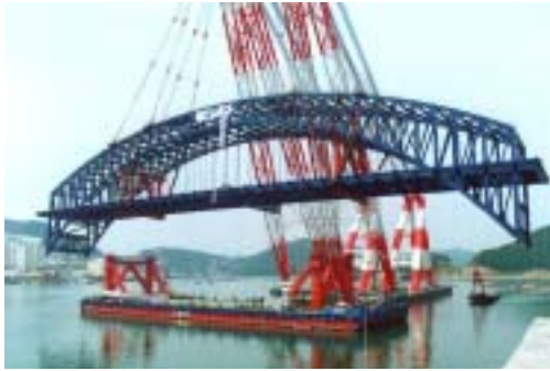
<그림 3-6> F/Crane을 이용한 일괄 선적
