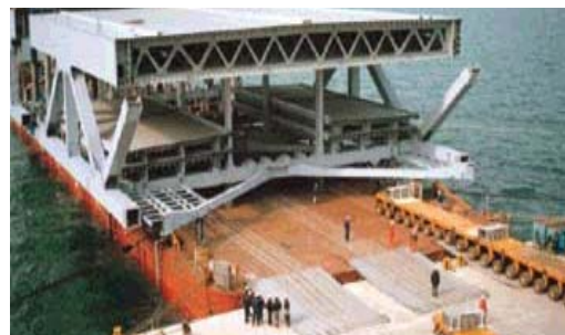
<그림 2-5> Transporter를 이용한 선적
