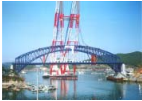
<그림 3-7> F/Crane을 이용한 일괄 설치
