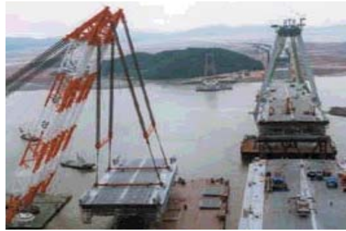
<그림 2-7> 해상크레인 이용한 설치
