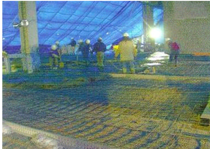
<보양작업후 콘크리트 타설>
