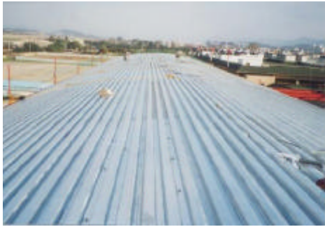
① Deck Plate 설치
