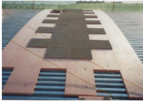
② 50M/M 단열재 시공
