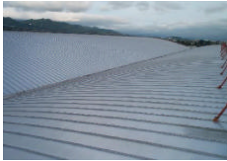
⑨ SST 지붕재 마감(Cap 시공완료)
