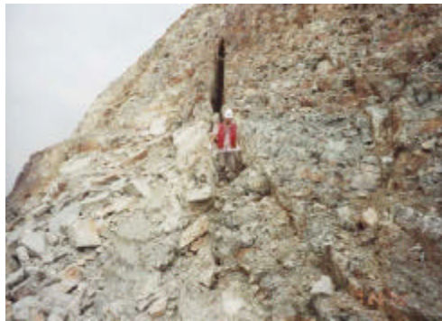
<그림 2-2> 균열발생부 전경
