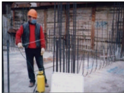
<철근 녹제거 Steel-Seal(약품처리)>
