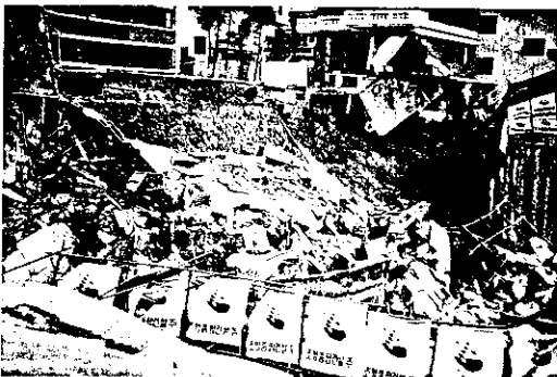
<그림 3-11> 안양○○타워 신축현장 지하흙막이벽 붕괴사고 현장
